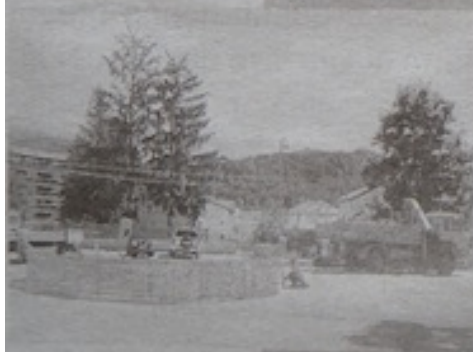
Il cantiere aperto a Pescasseroli
